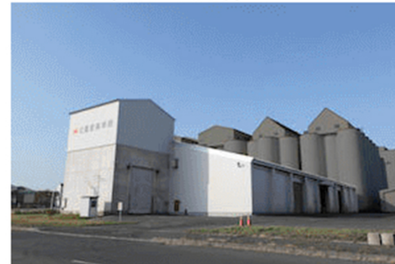
■西港区（西港1号倉庫）
